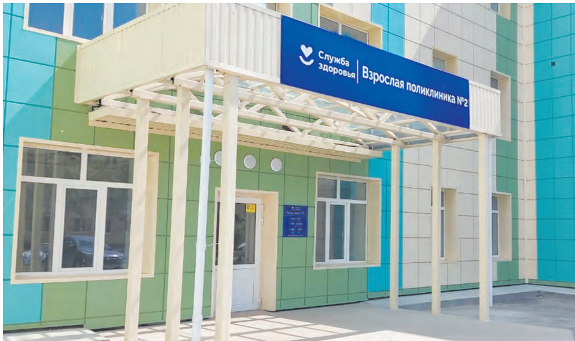
Поликлиника №2 после ремонта
