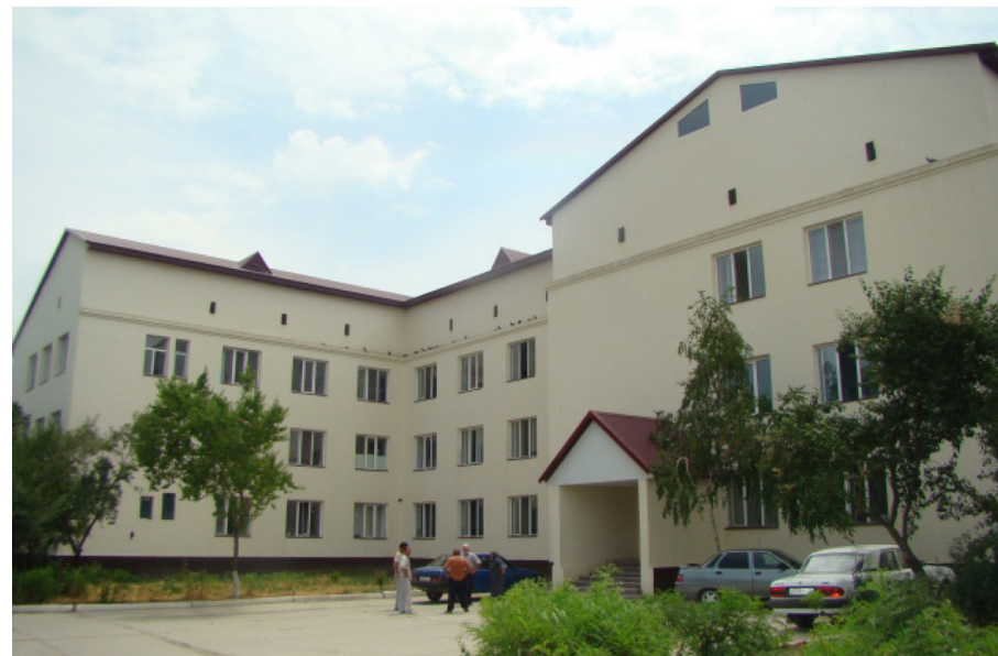
Главный корпус здания Бабаюртовской районной больницы после капитального ремонта
