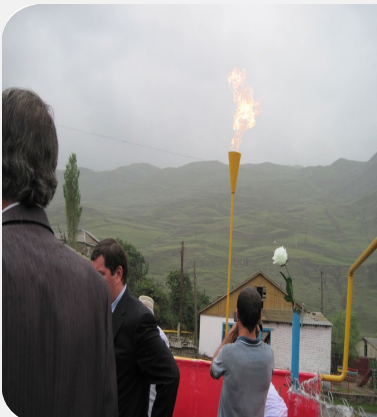
Завершение проведения газопровода Ашага-Сталь- Касумкент- Курах
